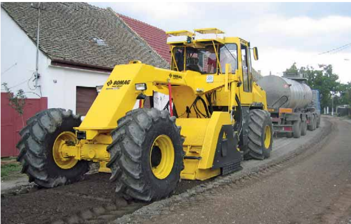
BOMAG MPH 122-2 estabilizando cemento.
