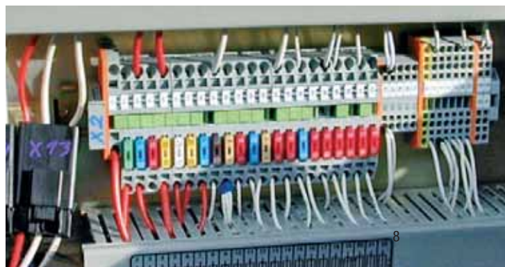
Equipamiento eléctrico con indicadores LED para un rápido diagnóstico de los fallos.
